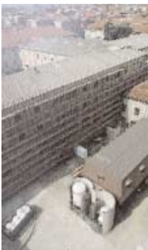
Lavori di adeguamento e potenziamento delle Strutture Architettoniche.
